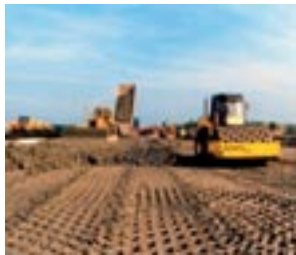
Schafffußwalzen planieren und verdichten die 60 cm dicke Dichtungsschicht aus Ton.
