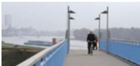
Die Prinzbrücke schafft einen Zugang vom neuen Rheinpark an den Rhein.
