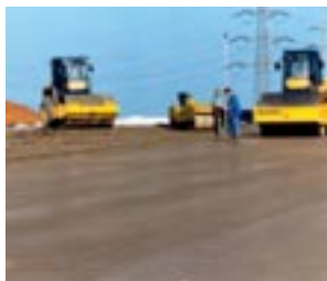
Präzise wird die Oberfläche der Tonschicht ausgemessen und für das Verlegen der Kunststoff-Dichtungsbahn vorbereitet.
