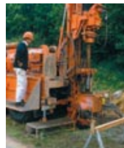
Im Bereich der Döhlnnaue-Nord werden sechs Grundwasser-messstellen gebohrt.
