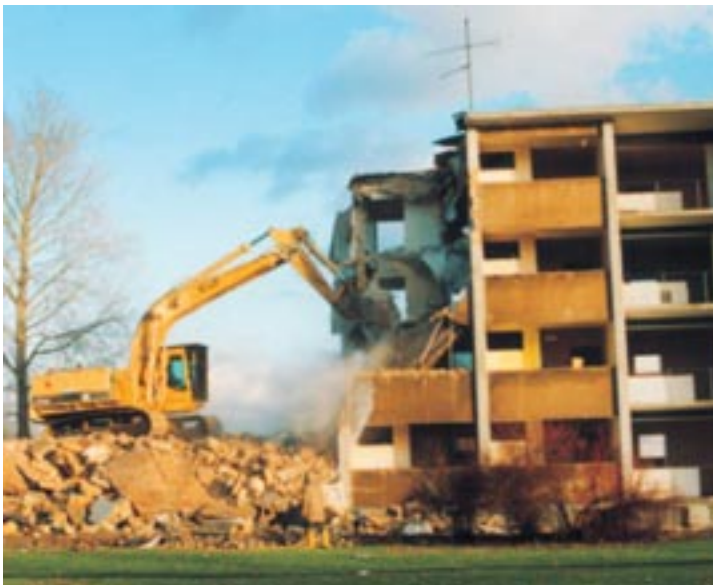
Im Januar 1993 werden die Häuser an der Rheinallee abgerissen.
